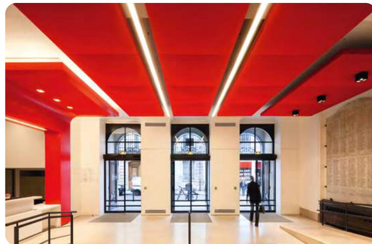
Panneaux Stereo suspendus en nappe. Dimensions paramétrables et insertion de spots lumineux. Paris, hall de Sciences Po. Architectes Cabinet Sahuc & Katchoura, Claire Leroux.
