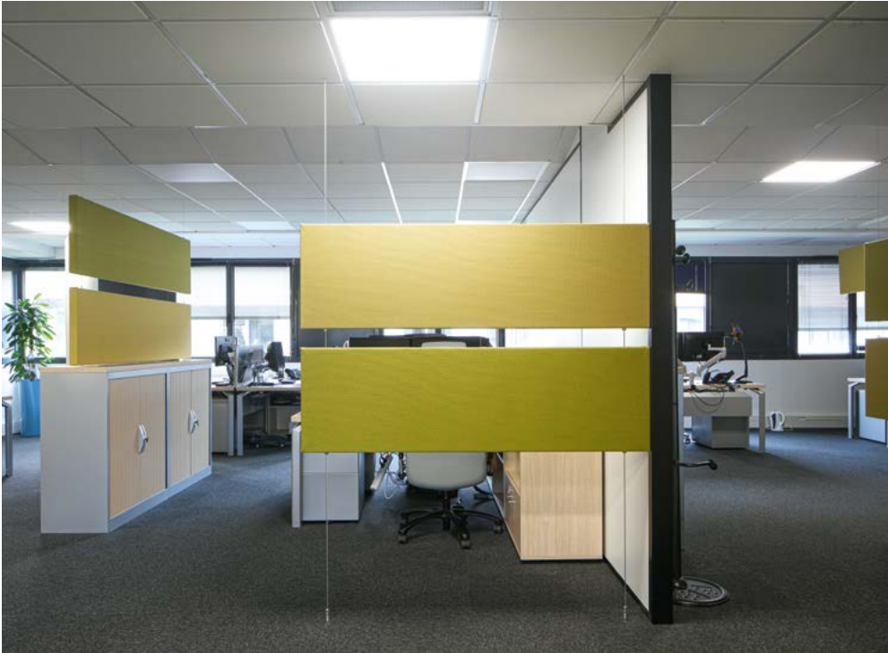
Panneaux acoustiques Stereo en séparateurs suspendus au plafond par câbles traversants ancrés au sol.
