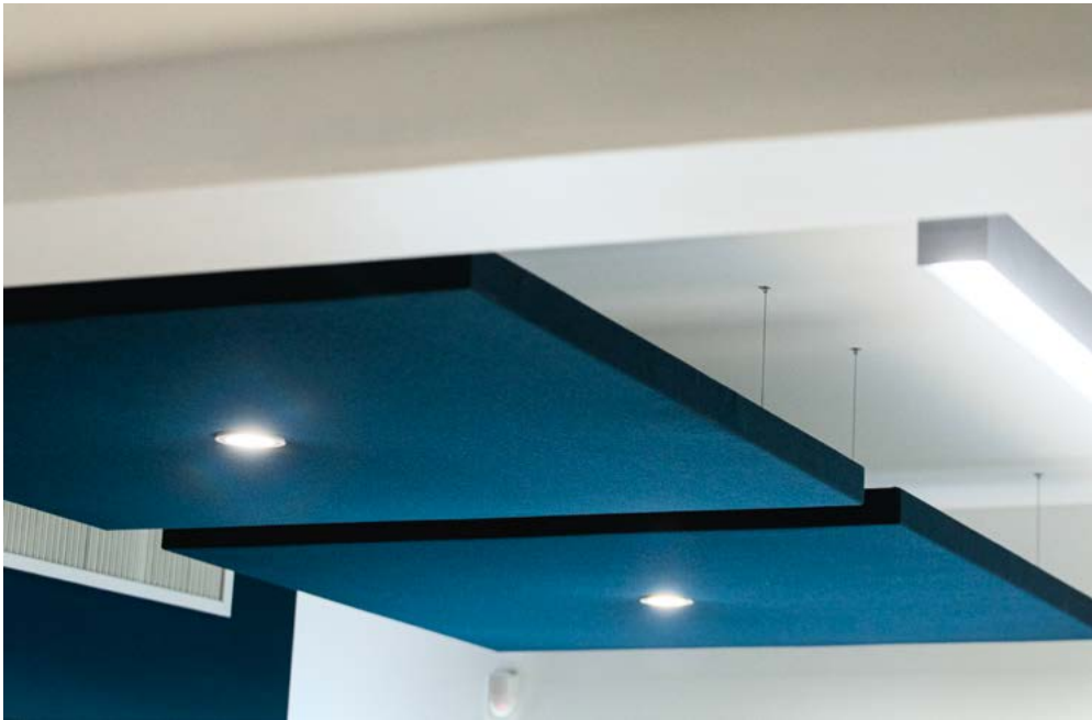
Panneaux acoustiques Stereo suspendus au plafond avec insertion de spots lumineux.
